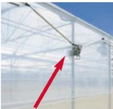
Aération latérale par Enroulement mécanique Central
