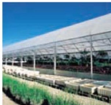
Aération latérale par Enroulement avec tube de maintien
