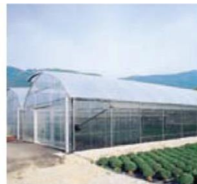
Aération latérale par enroulement brise vent et mécanisme d'extrémité
