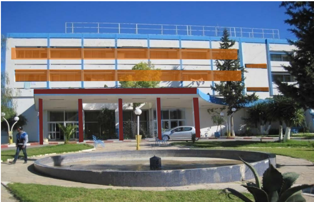
Figure 3.30 : Façade principale du Hammam
