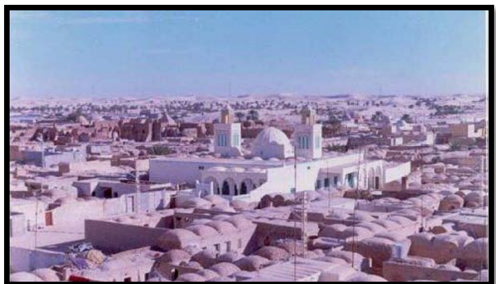
Figure 2.4 :Utilisation des coupoles dans l'architecture vernaculaire
