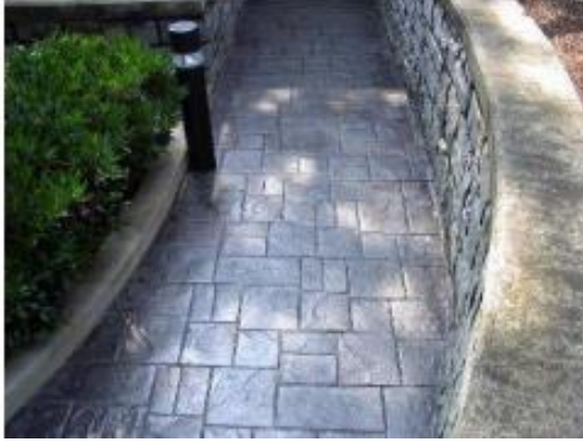
Béton imprimé Usage dans les trottoirs et chemin tertiaire
