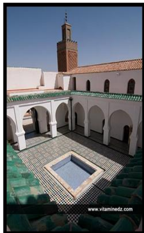
Figure18 :La mosquée de Sidi Brahim
