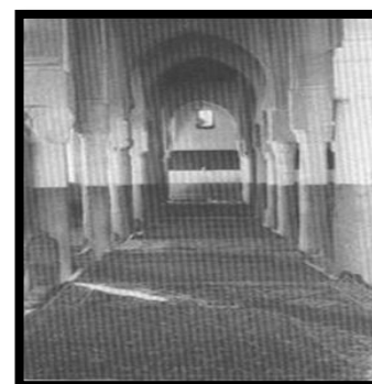
Figure44 :Arcs brisés et impostes de la mosquée du Vieux-Ténès
