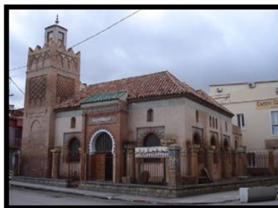
Figure17 :Travaux de restauration de la mosquée de Sidi Bel –Lahcen 2003
