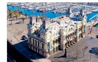
L'ancien administration du port réhabiliter
