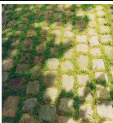
Pavé de grés de joint engazonnes
