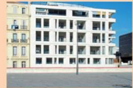
Reconstruction d'un immeuble
