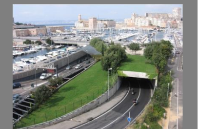
Création du tunnel sur RN02
