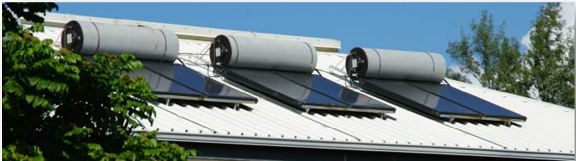
figure3 : système solaire thermique à basse température (chauffe-eau solaire)
