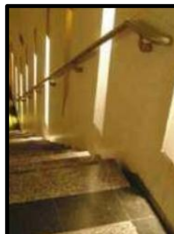
Figure 33 : main courante d'un escalier
