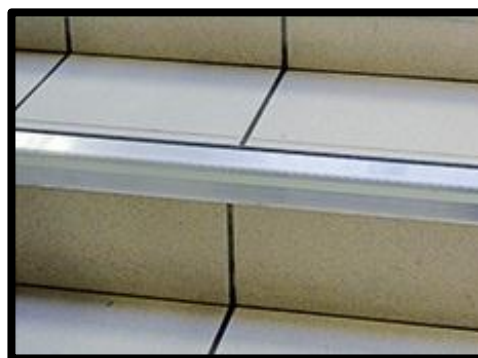
Figure 32 : nez de marche d'un escalier
