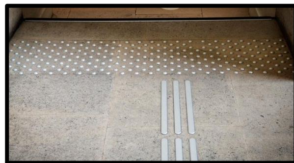
Figure 25 : traitement de sol
