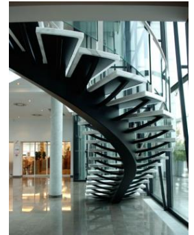
Figure 140:escaliers métallique a limon
