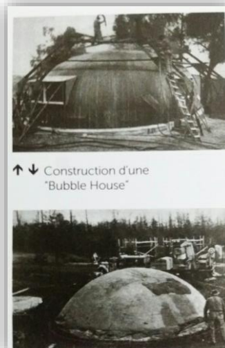
Figure 55: construction d'une Bubble House
