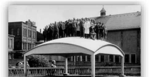
Figure 21:Coque d'essais de Dywidag en voile mince
