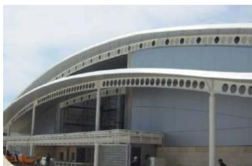
Figure 130: poutres alvéolaires Courbées Limassol Sports Hall, Cyprus.
