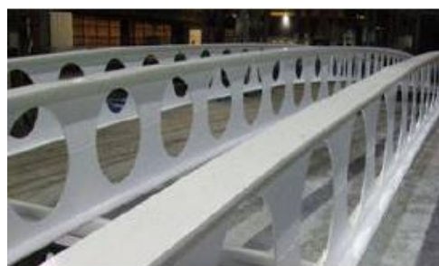
Figure 129: poutre alvéolaire IPE 78 + planché collaborant
