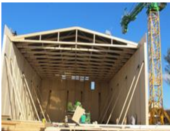
Vue de La salle en cour de réalisation
