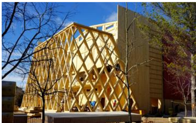
L'ossature de la Façade principale
