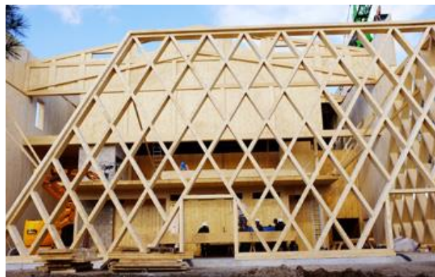
L'ossature de la Façade principale
