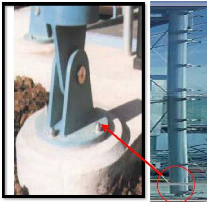
Fixation des poteaux tubulaires
