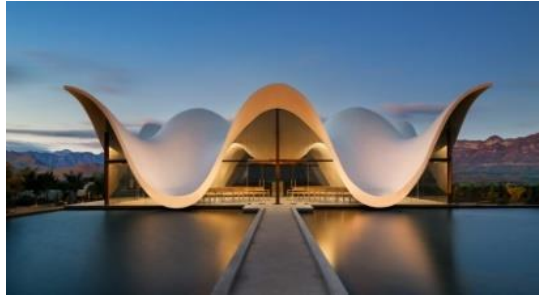
figure 56:Chapelle de Bosjes par Steyn Studio ; sud afrique ; 2016
