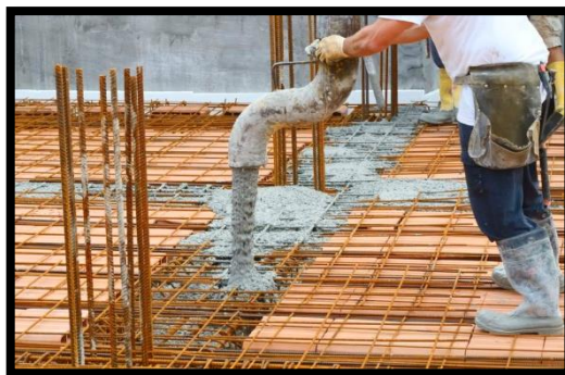
figure 149:Application de béton sur des armatures
