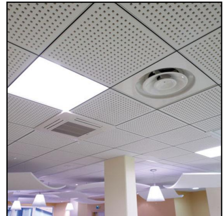
figure 163: exemple faux plafond en plâtre perforé
