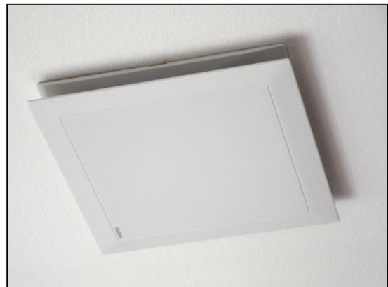
figure 170: Bouches d'extraction
