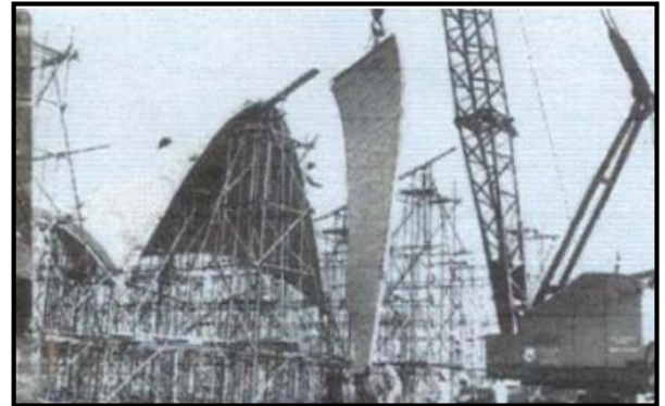
figure 137: Les éléments préfabriqués étant placés en position
