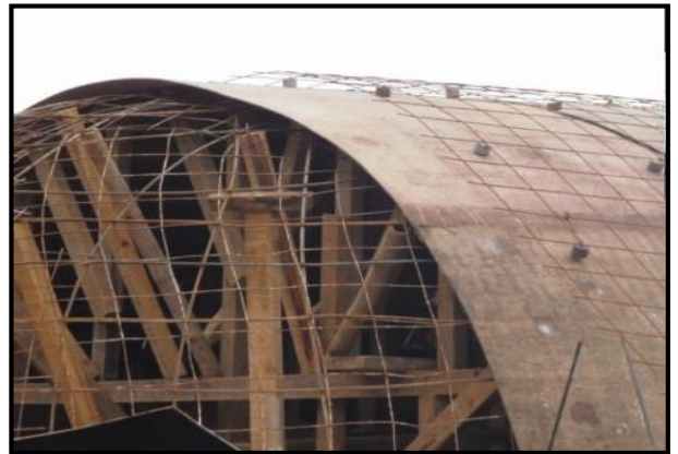
figure 135: Mise en place du coffrage et armature
