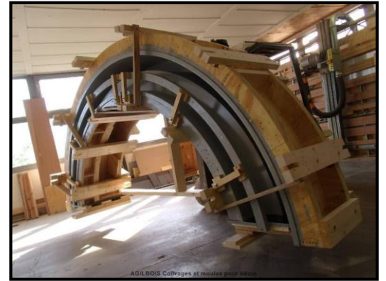
figure 142: fabrication du coffrage en bois pour le béton par l'entreprise AGILBOIS.
