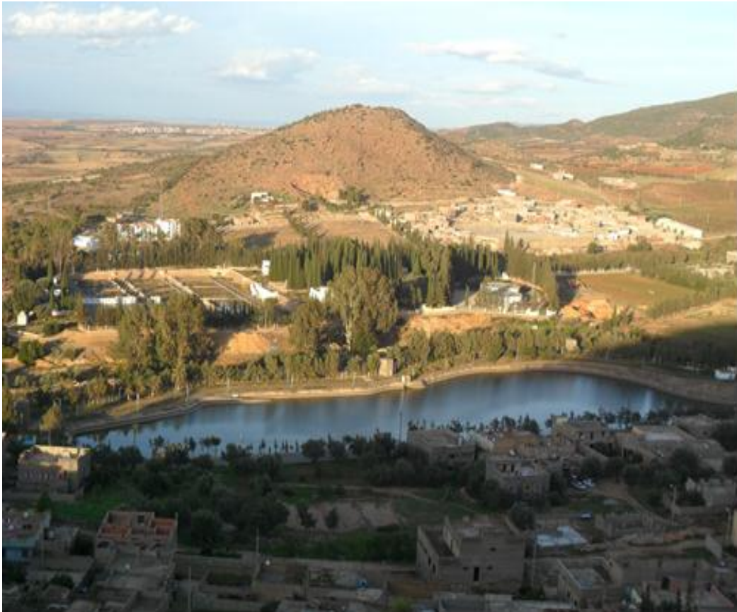
Figure I.9 : bassin de compensation Bouhlou [9].
