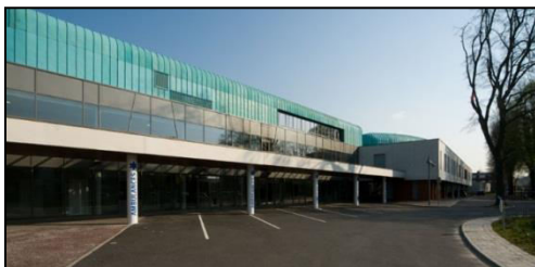
Figure 21: l'accès à l'hôpital du jour
