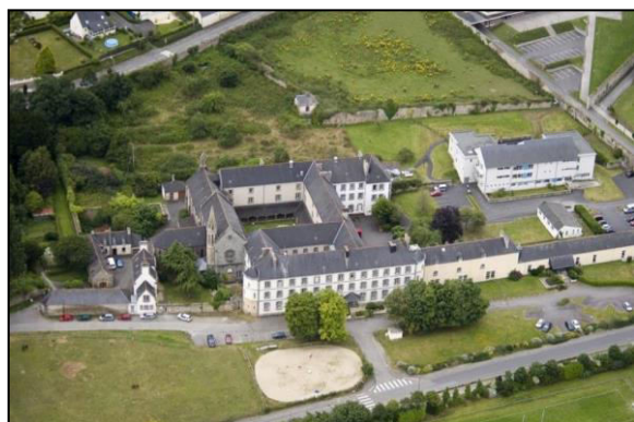
Figure 51: vue aérienne de Kerlaouen avant la démolition
