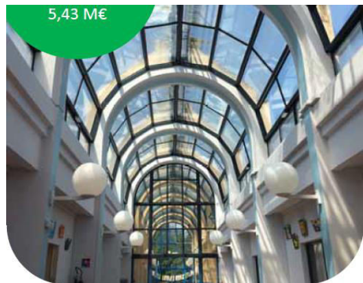
Figure 41: le passage couvert arqué (verrière)
