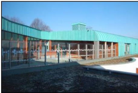
Figure 25: vue extérieure sur l'école du CRF
