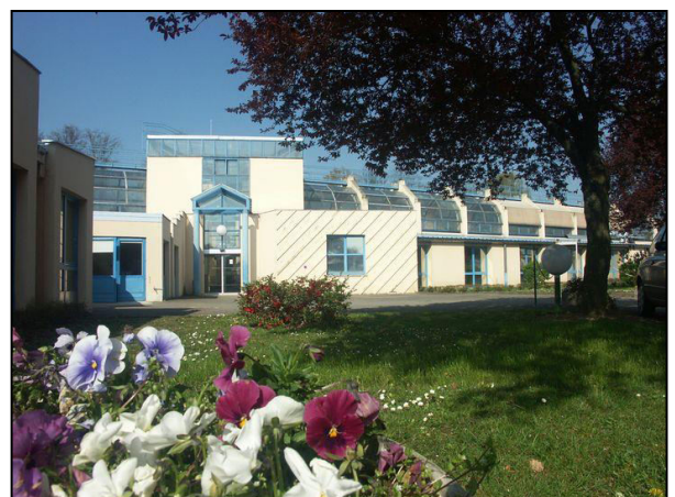
Figure 42: vue sur la façade principale
