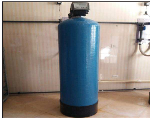
Photo.4 : Le filtre à sable de la station de l'EPH [Source :Sarra&Khadidja]
