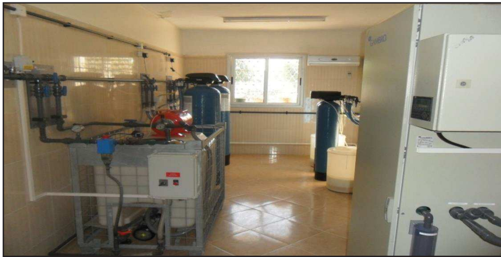
Photo. 2: La station de traitement de l'eau de dialyse EPH Maghnia [Source :Sarraf&Khadidja]
