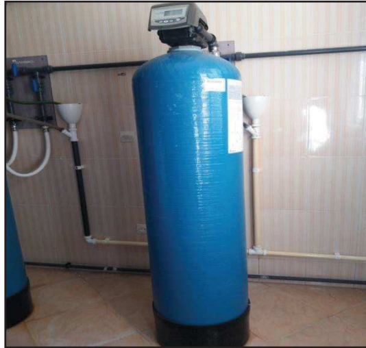
Photo.5: Filtre à charbon actif de la station d'EPH [Source :Sarra&Khadidja]
