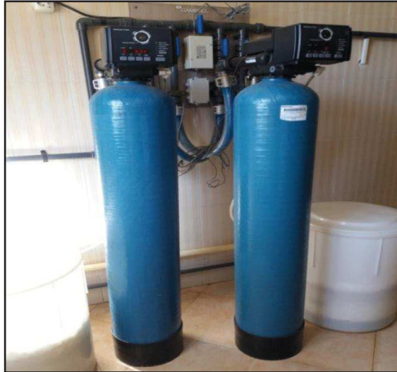
Photo.6 : Système adoucisseurs de la station de l'EPH [Source :Sarra&Khadidja]
