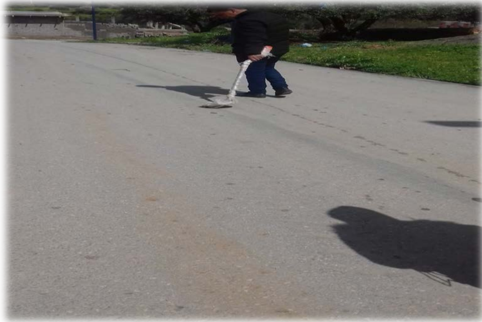
Figure III.1 : Détection d'un regard (Sidi Mohammed).
