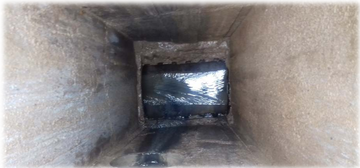
Figure III.20 : Un regard avec une profondeur de 3,1 m (Hmalil).
