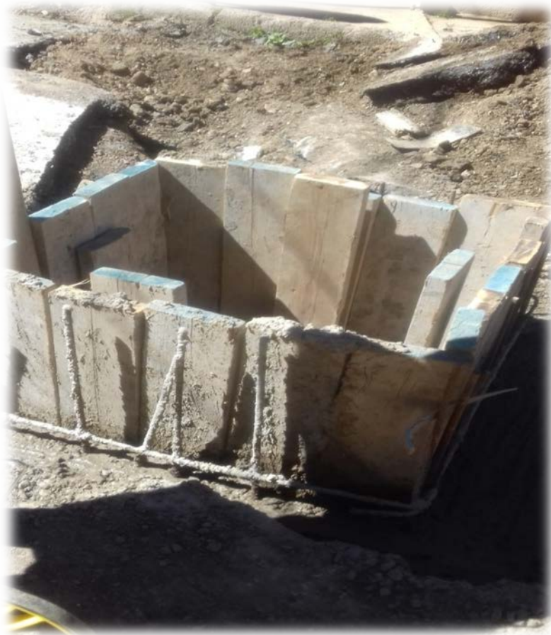
Figure III.18 : Coulage du béton d'un regard (City d'olivier 2).
