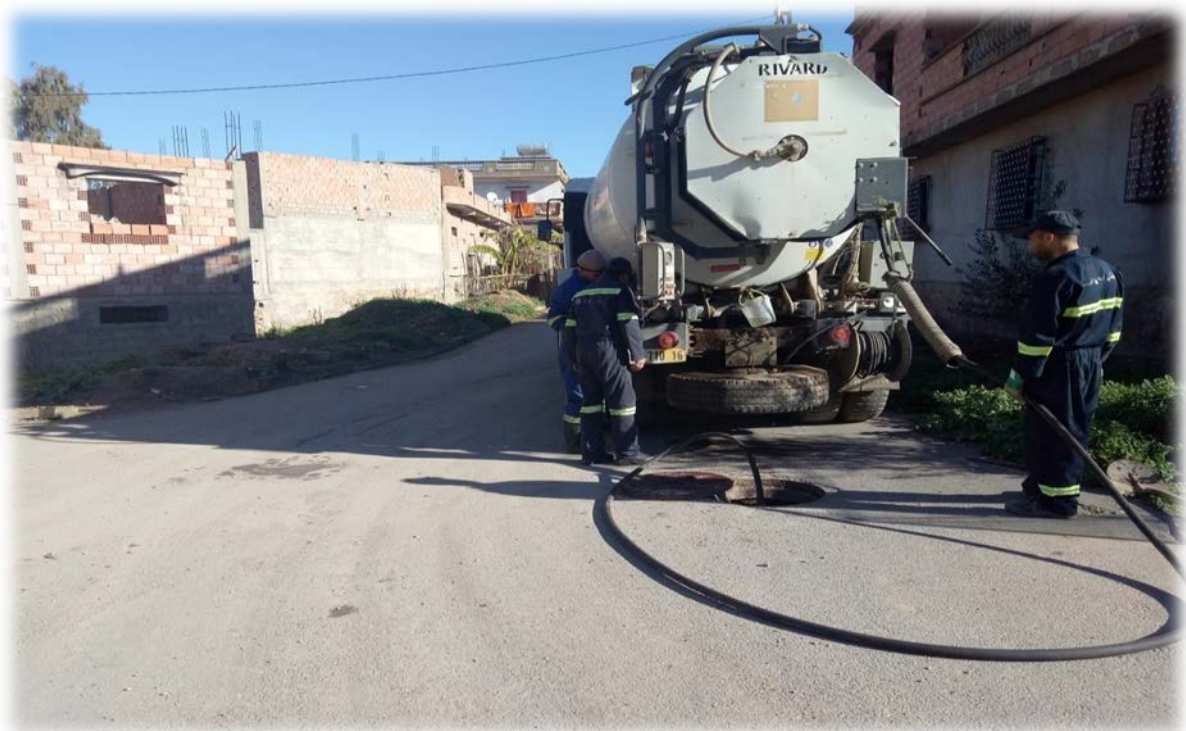
Figure III.6 : Un hydrocurage d'un collecteur (camion hydrocureur).
