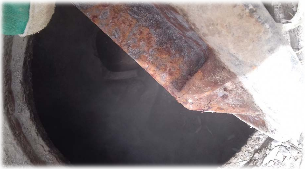
Figure III.36 : Regard n'est pas en service.
