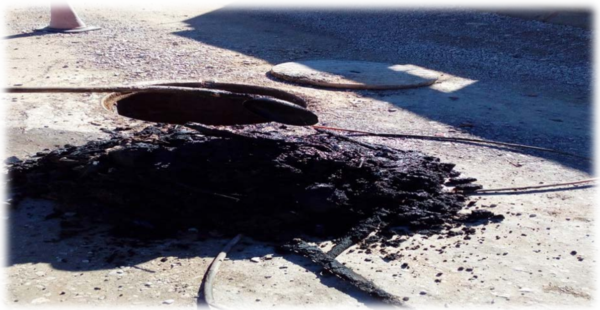
Figure III.39 : Les déchets bouchant les regards.
