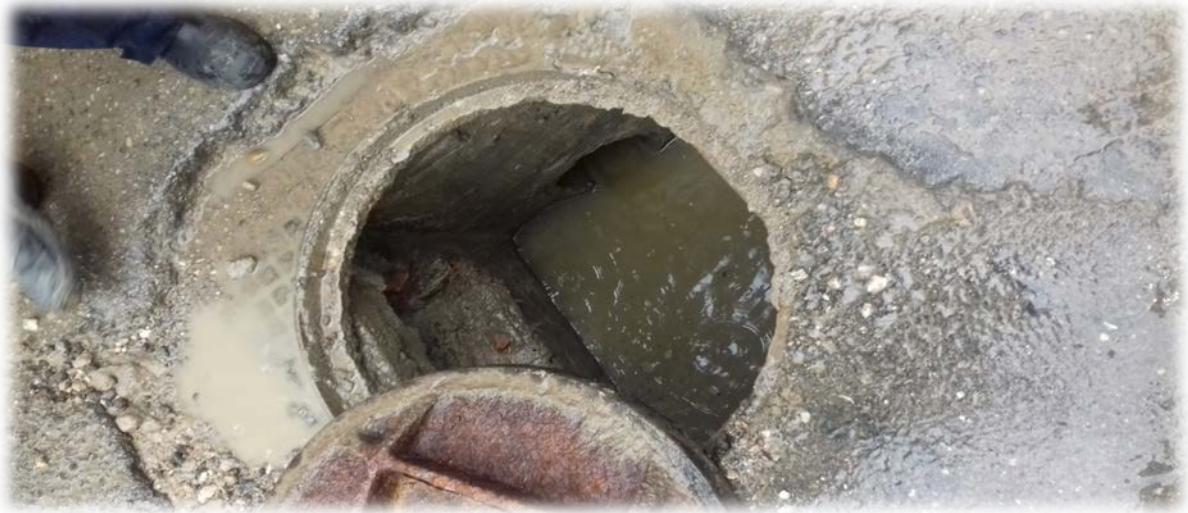
Figure III.21 : Un regard de deux sorties et avec une profondeur de 1,3 m (Centre de Bensekrane).
