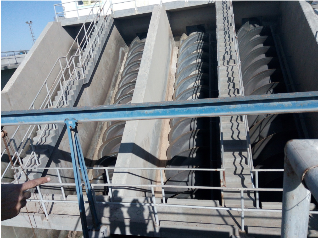
Figure II.11 : Vis d'Archimède.
