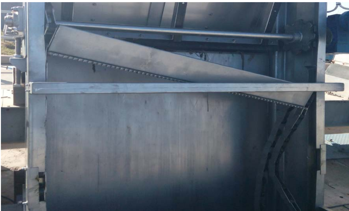
Figure III.21 : Le déplacement de chaîne dans un dégrilleur.
