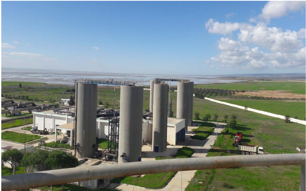
Figure II.18 : Les silos de boues.
