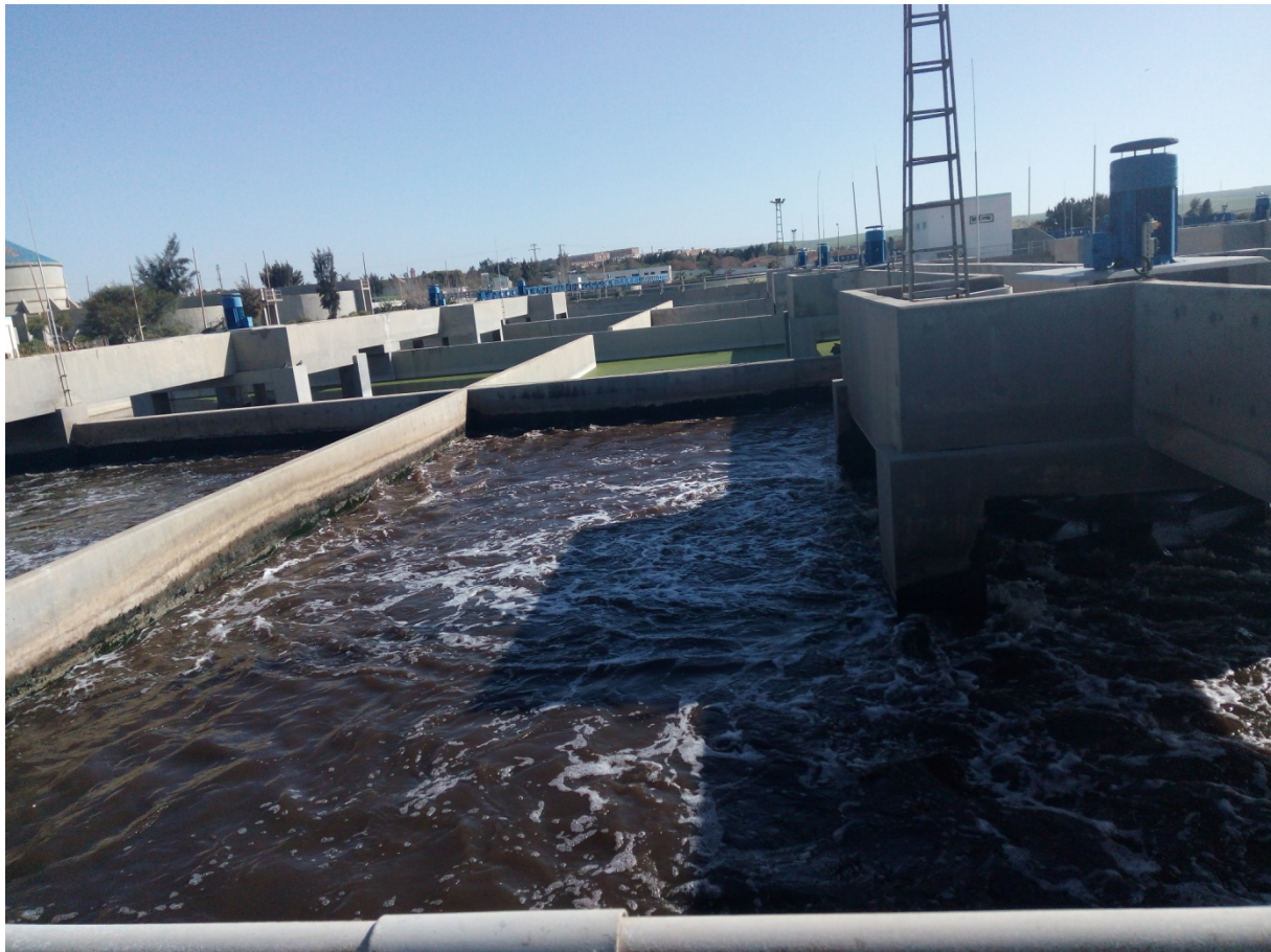
Figure II.8 : Bassin d'aération de la STEP D'EL KERMA
