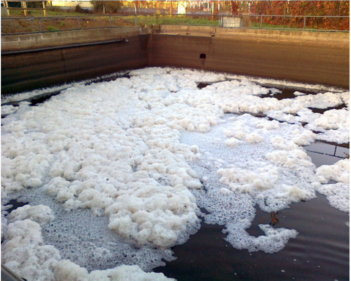
Figure I.3 : La mousse biologique présente dans les bassins d'aération. [8]
