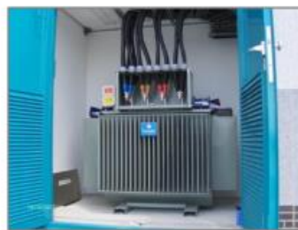
Figure 228 : poste transformateur
