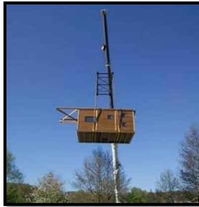
Figure 87 : La pose de l'enveloppe
