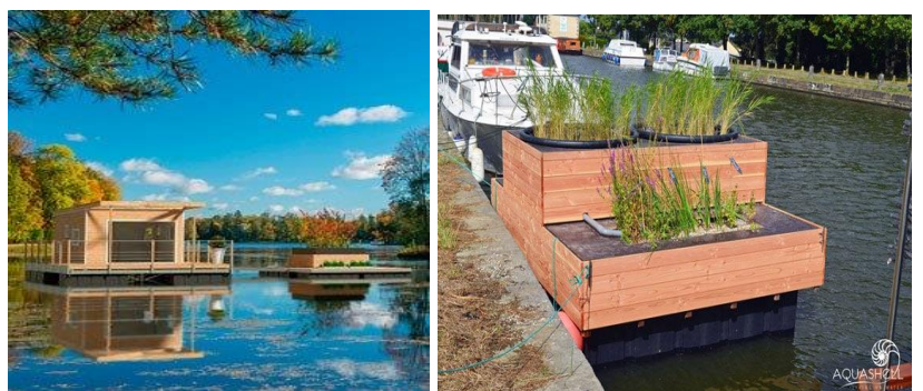
Figure 223 : traitement par le système de phytoépuration flottante
