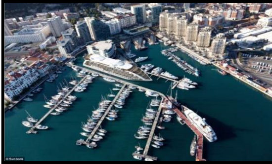
Figure 40 : Quais flottants au port de plaisance de Gibraltar
