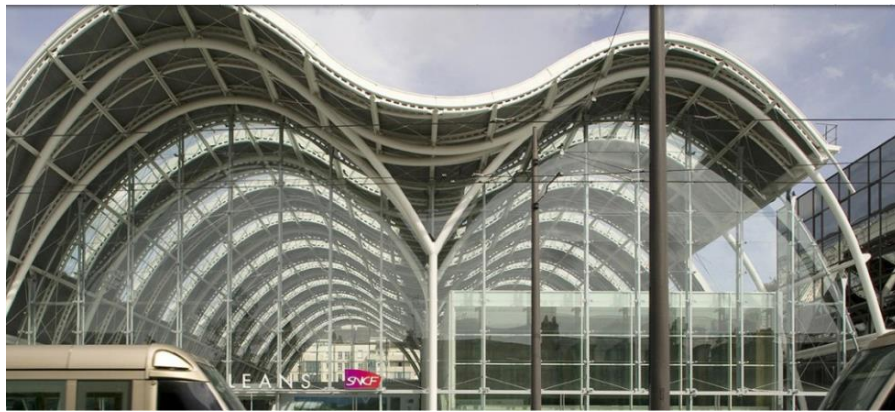
Figure 208 : toiture en poutres alvéolaires
