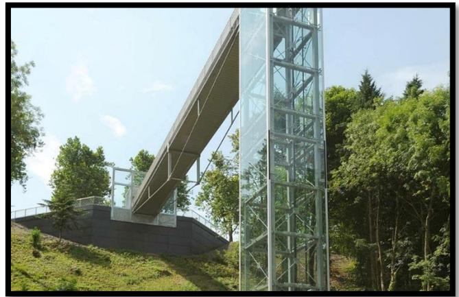
**Figure 118:l'ascenseur urbain en charpente métallique du Mont Russel et du Boulevard de la Dollée A SAINT-LO**
