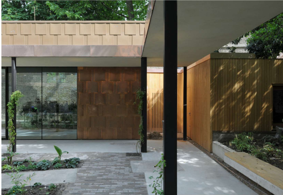
Figure 79 : vue sur les trois pavillons injectés
