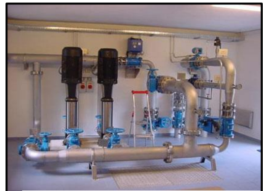
Figure.80.station de pompes
