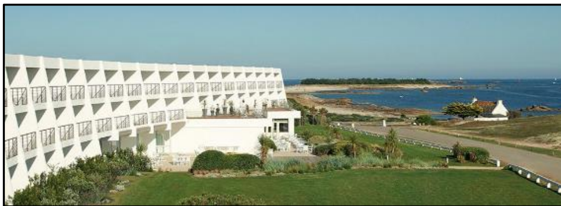
Figure.14.façade principale du complexe « Sofitel Thalassa »
