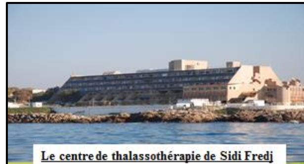
Figure.19.vue globale du centre de Sidi Fredj
