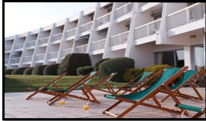
Figure.09.vue sur la façade de l'hôtel Thalassa Quiberon
