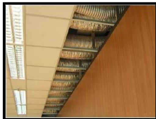
Figure95: Passage des gaines
