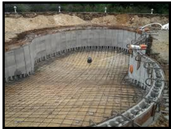
Figure 99: Le coffrage d'une piscine
