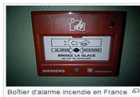
Figure 59: boîte d'alarme incendie
