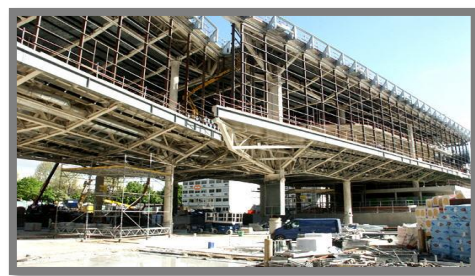
Figure 144: La structure en acier du musée.
