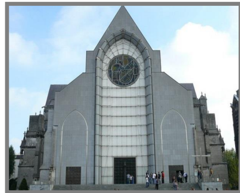
Figure 13: La structure horizontale en acier s'étend entre colonnes.
