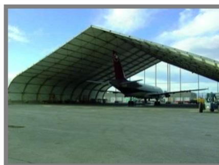
Figure 34: Hangar pour avion.
