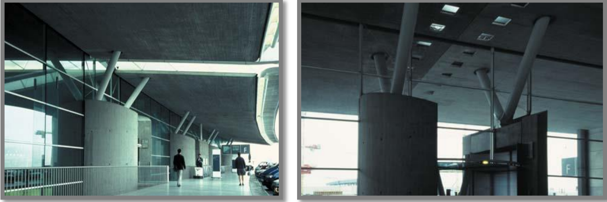
Figure 16: Une «colonne fractionnée» vue de l'intérieur.
