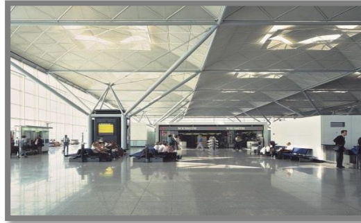
Figure 14: Les «arbres» portiques sont une extension de la structure intérieure.
