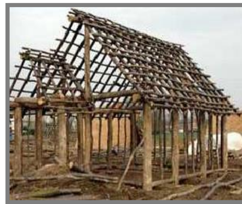
Figure 4: Structure et charpente en bois.
