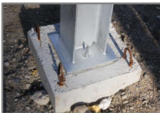
Figure 202: Fondation des poteaux métallique
