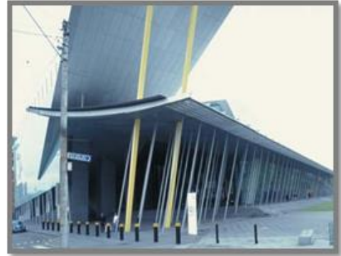
Figure 12: Les poteaux de véranda.
