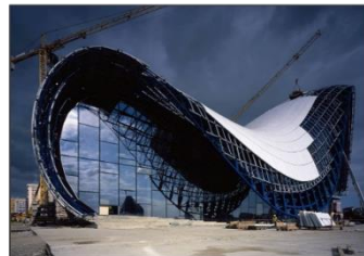
Figure102: Pose du revêtement de la structure
