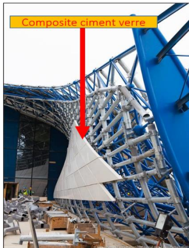
Figure102: Pose du revêtement de la structure
