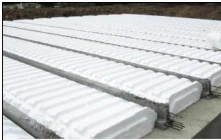
Figure 149: Isolation thermique des planchers
