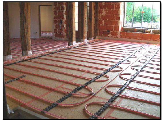
Figure 154: Chauffage par le sol
