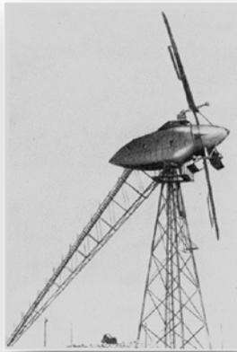
En Russie, afin de produire une puissance unitaire plus importante, ils arrivent à installer en 1930 une éolienne de 30m de diamètre à Balaklava (Crimée), construite par l'Institut Central de l'Énergie du Vent (ZAHV) de Moscou (*Figure I.6*), sa puissance nominale atteinte est 100 kW à une vitesse de vent de 10.5m/s [1] [44].
