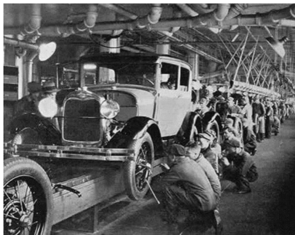
Figure I-2 : Chaîne de montage au cours de la seconde révolution industrielle[3]
