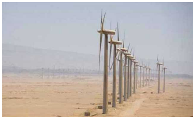
FIGURE I.6 – Première ferme éolienne du pays inaugurée à Adrar [54]
