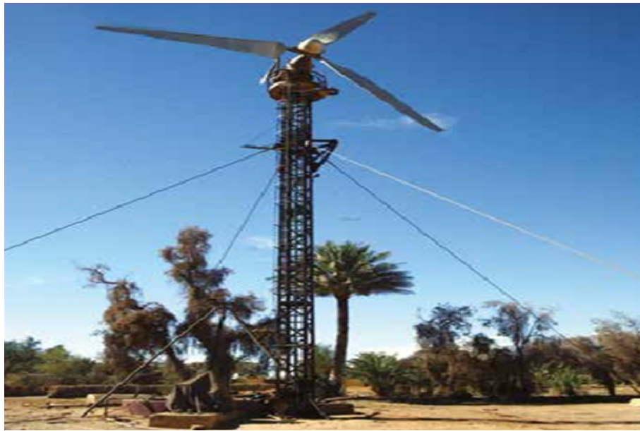
FIGURE I.5 – Première éolienne installée en Algérie [3]
