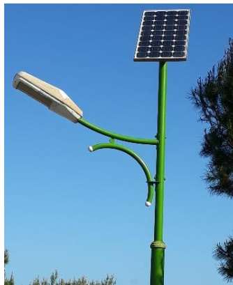
Figure 1-2 : Exemple d'un système PV autonome (éclairage public CDER)
