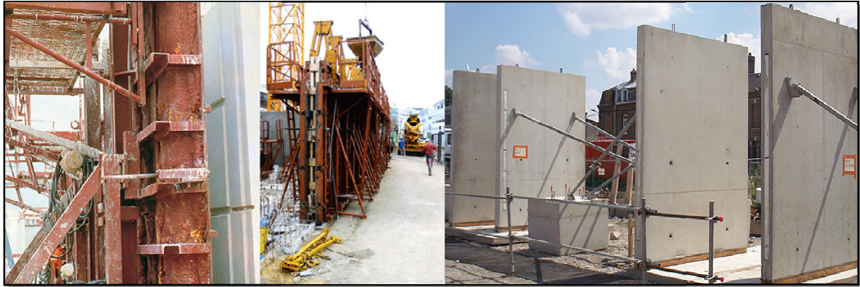
Figure I.4 : Construction de voiles en béton armé.
