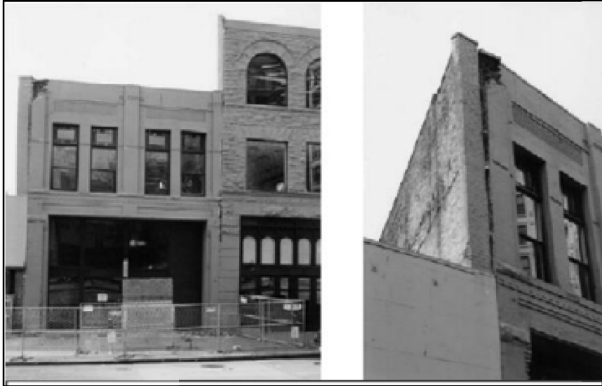
Figure IX.5 : Séparation des deux bords des bâtiments adjacents.
