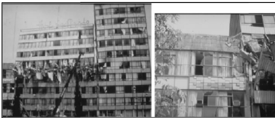
Figure IX.6 : Effondrement des planchers du milieu (Mexique, 1985)
