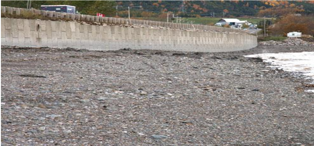
Figure 5.13 : Mur de soutènement (Gaspésie).
