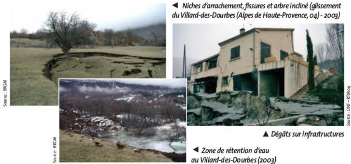
Figure 4.4 : Quelques exemples des phénomènes induits par les glissements
