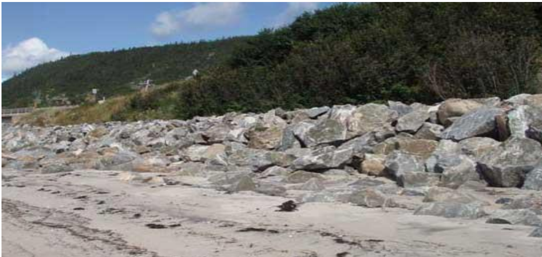
Figure 5.14 : Protection de falaise par enrochement.
