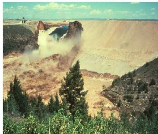
Barrage après la rupture
