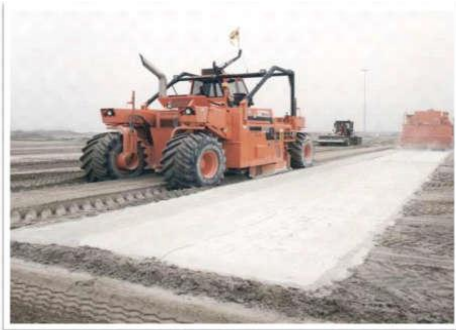
Figure 3.4 : Stabilisation au ciment. (NEDJAH I A et DJOUDI. A, 2015).
