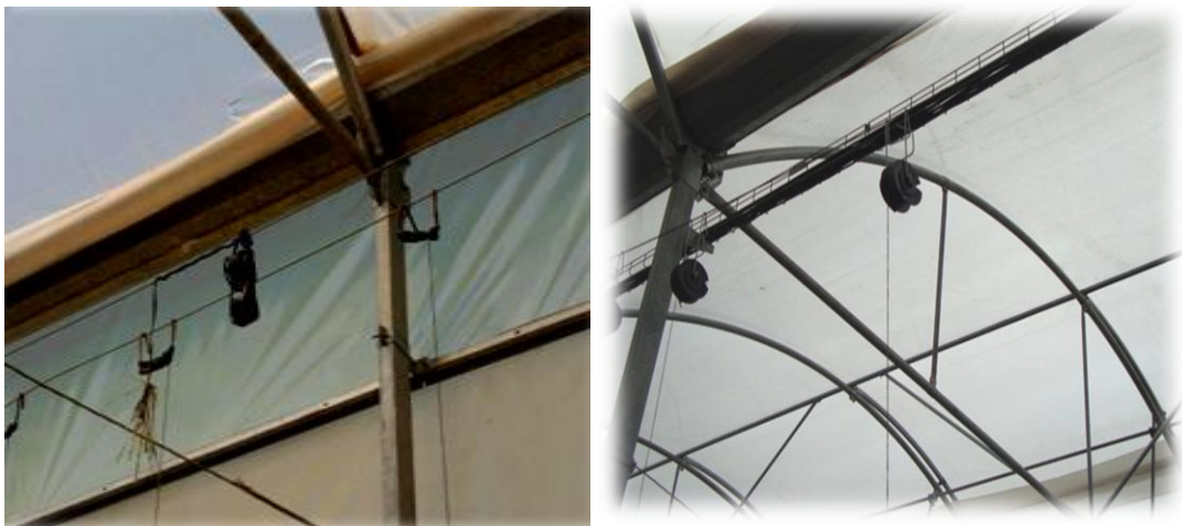
Photo N° 7: Mise en place du palissage
