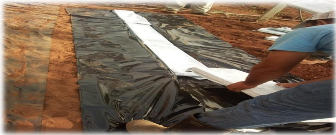
Photo N°3: Mise en place de la fibre de noix de coco.
