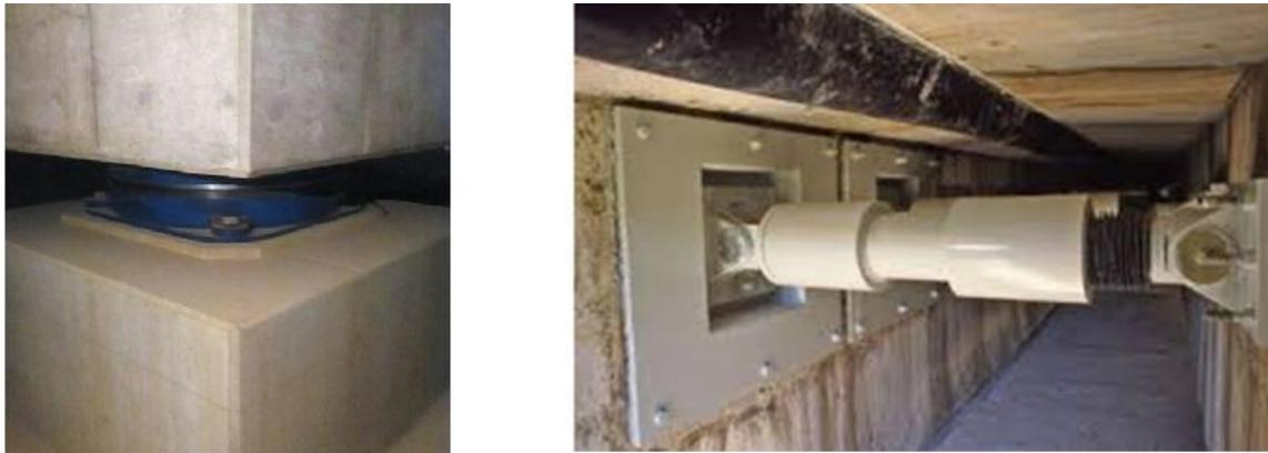
Figure 1-3 : Isolation sismique, à gauche : appui en élastomère (grande mosquée d'Alger), à droite : amortisseur dissipatif (VINCI-Construction)
