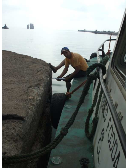
Photo III.14 :Auscultation mécanique des ouvrages portuaires au scléromètre.
