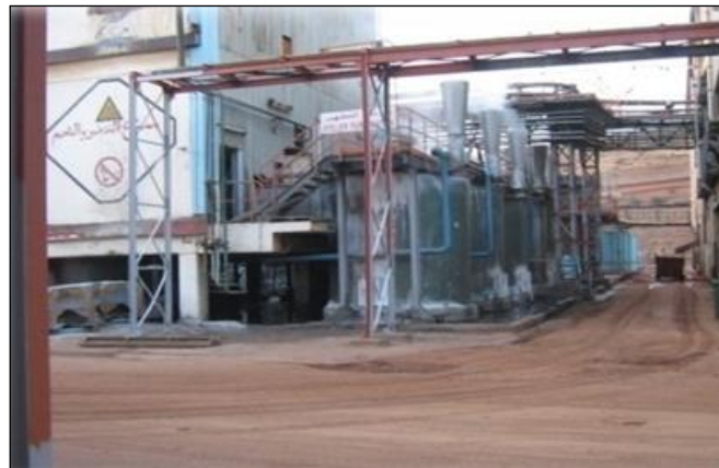
Figure 1.5 : Vue de l'atelier lixiviation.
