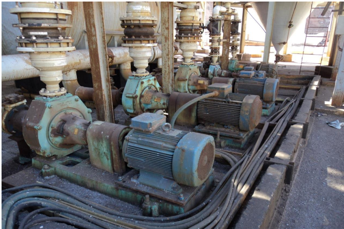
Nettoyage et vidange du compresseur et des pompes
