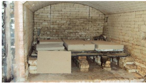
Figure 1.1. Restauration de l'habillage intérieur d'un four brique et dalles réfractaires dans le CERTAF de MAGHNIA
