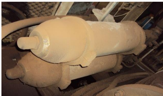
Figure 2.33. Les deux accumulateurs de la presse MATRIX HS 550L
