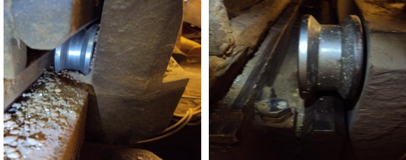
Figure 4.5. Nettoyage de chemin des poulies
