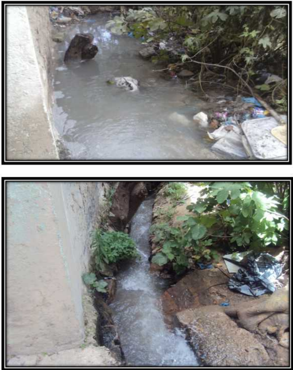
figure IV - 10 -: Photos prise en 2013 montrant les eaux usées destinées pour l'irrigation
