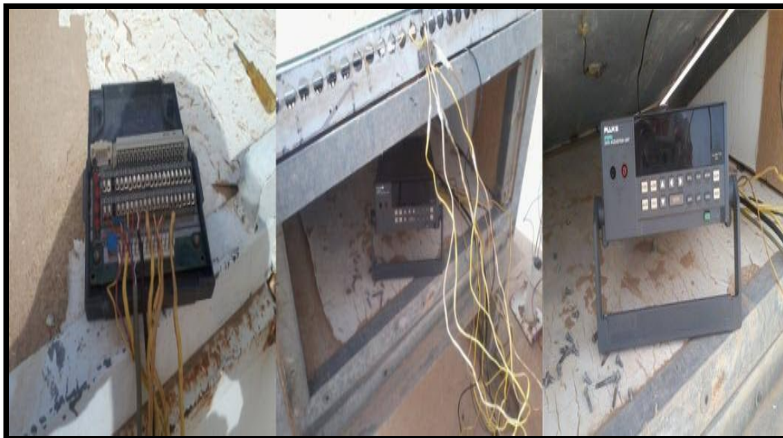
Fig IV.10 : Photos représentent le raccordement des différents thermocouples à l'acquisition de données
