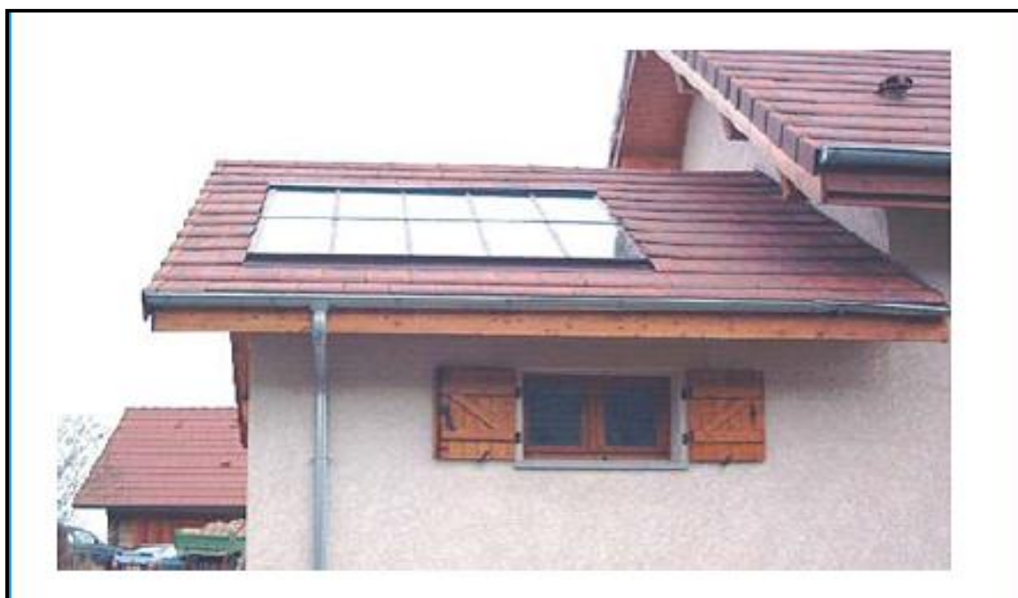
Fig II.10: Photo représentant un Chauffage d'habitat par un capteur plan à air
