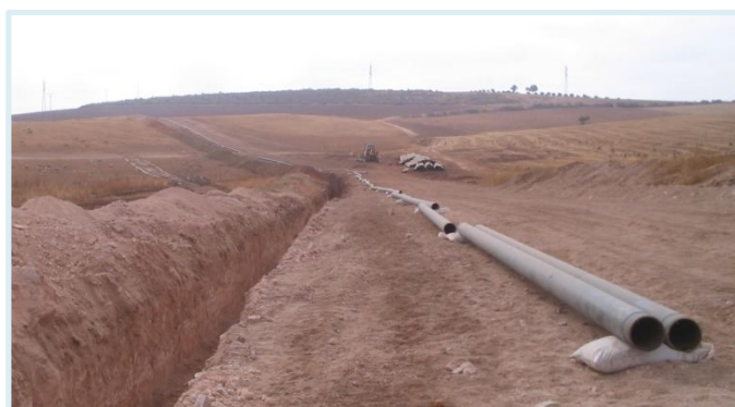
Figure 3.7 Tubes du pipeline MP/ ASR alignés pour soudure(10)
