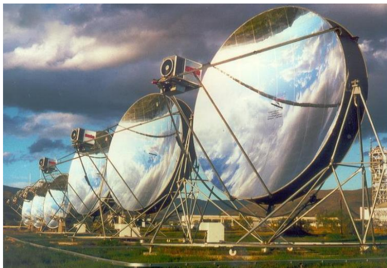
Fig. 1.6 : Capteurs solaires paraboliques
