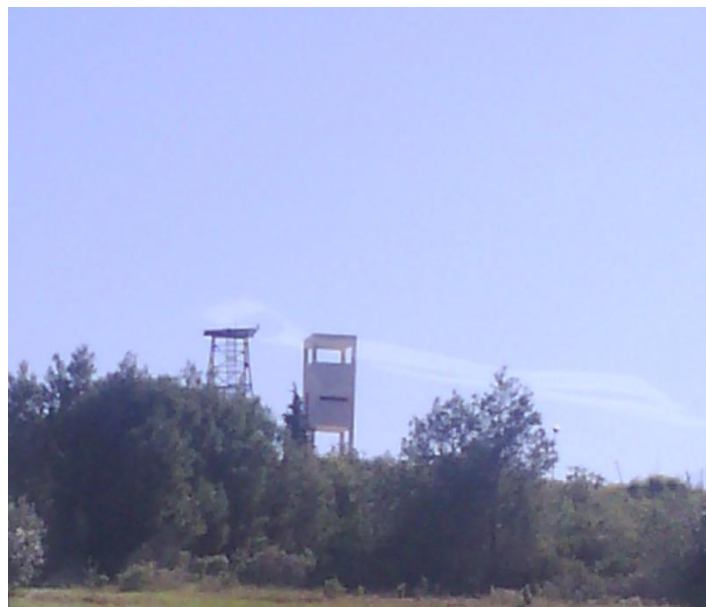
Photo 04 : L'état d'un poste de vigie métallique dans la forêt de Guétarnia la Daïra de Sfisef
