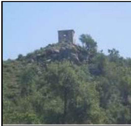
Photo 01 : Poste vigie (C.F.R., 2015)
