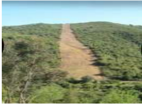
Photo 04 : Tranchées pare-feux (C.F.R., 2014)
