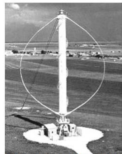
Schéma du rotor de Darrieus [31]
