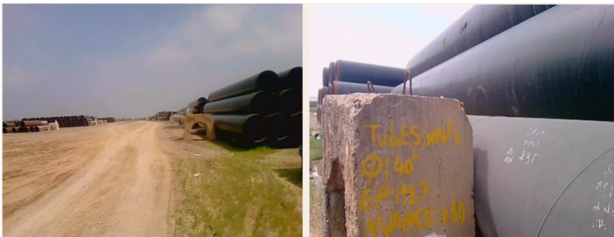
Figure II.1 : lieu de stockage des tubes (STT)
