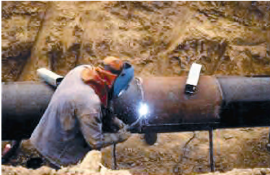
Figure II.31: Opération de soudages de demi coquilles(STT)
