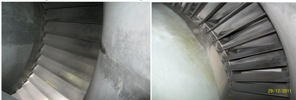
Fig.2.34.les aube directrice de l'air (IGV) [3]
