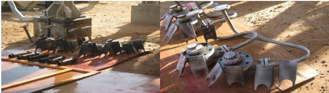
Fig.2.41.résultat de l'inspection sur des tubes d'interconnexions et languettes de fixation et les injecteurs [3]
