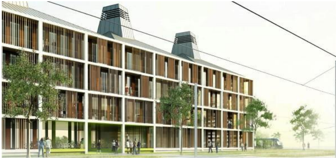
Figure III.10: Cheminées solaire de l'immeuble Michelin à Bordeaux
