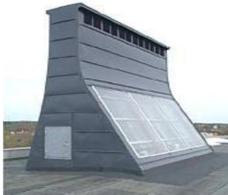
Figure III.12: Cheminée solaire extérieure
