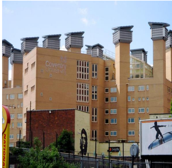
Figure III.13 : Tours à vent. Bibliothèque Lancaster, Université de Coventry – Angleterre
