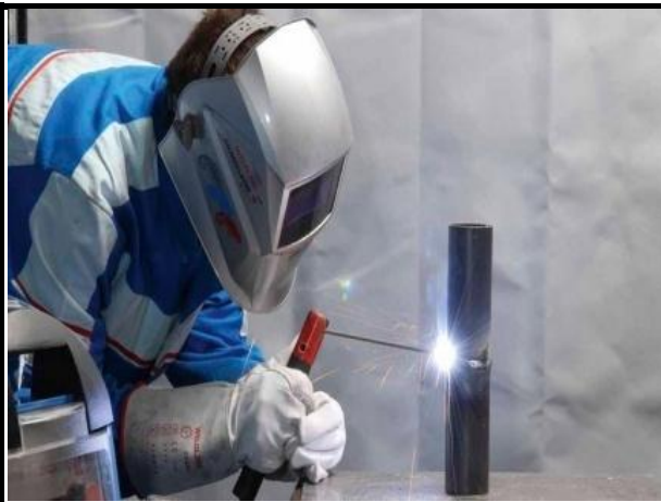
Figure 01 : soudage à l'électrode enrobée ou MMA (Manuel Metal Arc)
