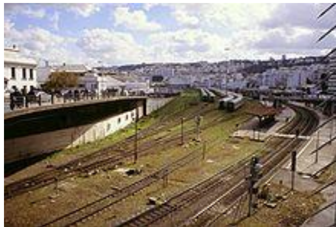
Figure IV.2 : Gare SNTF d'Agha à Alger
