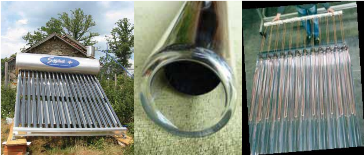
Figure III.6 : Capteur solaire sous vide.
