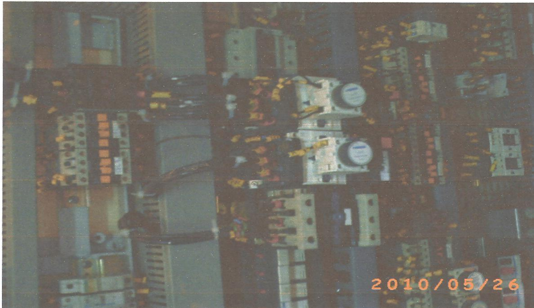
Figure IV.7 : Tableau de sécurité frigorifique [26].
