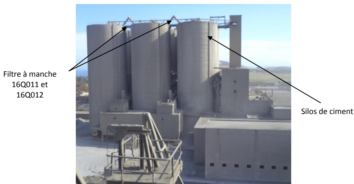
Figure 4.7: Emplacement de filtre à manches 16Q011 et 16Q012
