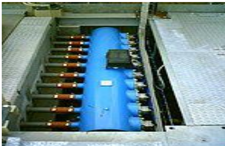
Figure 3.3: Réservoir d'air comprimé pour le décolmatage des manches filtrants
