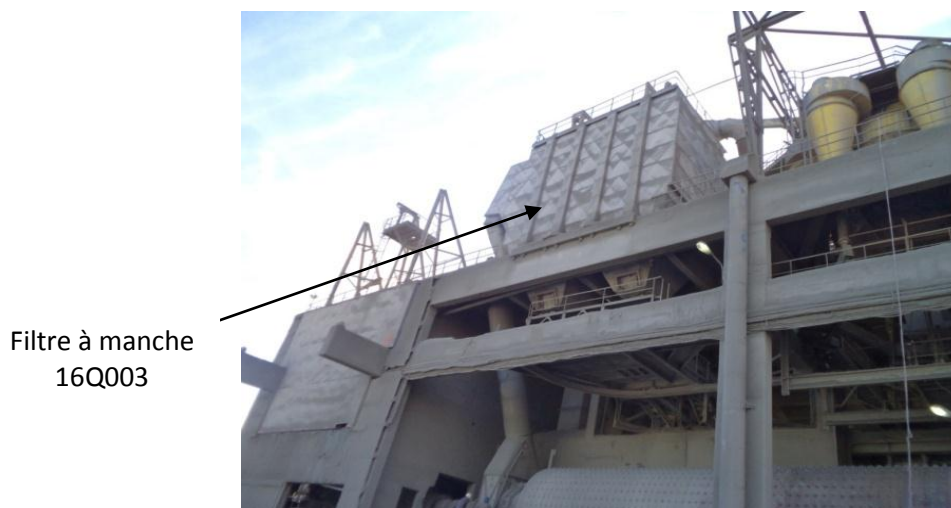
Figure 4.6: Emplacement de filtre à manches 16Q003
