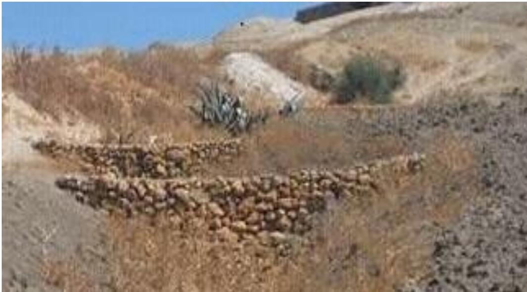
Photo n° 5 : Ravin aménagé par des seuils en pierres sèches (Mars, 2017)
