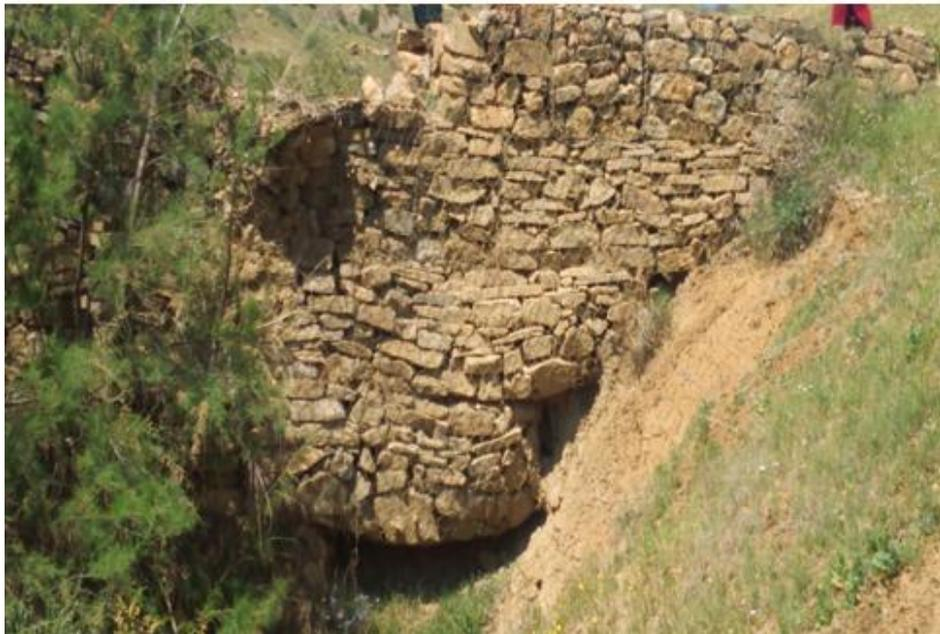
Photo n° 16 : seuil en gabion instable à cause d'une mauvaise fondation
